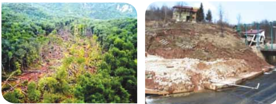
Slika 136: Veliko klizište u Bogatićima (2010) koje je uništilo hidroelektranu i dio šume
